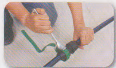
4. Kencangkan mur pengunci dengan alat bantu pengunci sampai batas akhir ulir.
