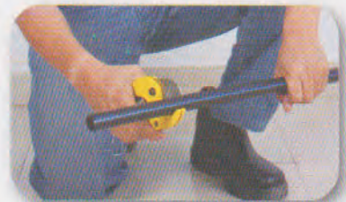
1. Potong tegak lurus pipa PE Blue Line dengan alat pemotong (gunting pipa).
