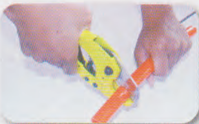
1. Potong pipa dengan tegak lurus.
