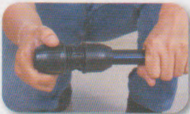
2. Kendurkan mur pengunci di fitting sejauh 2 atau 3 ulir tanpa harus melepasnya.
